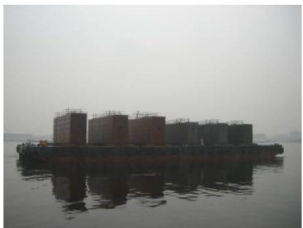
橋脚ブロックの海上輸送
