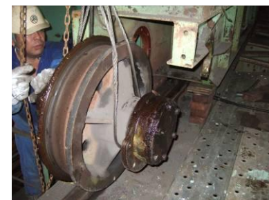
クレーン車輪取替作業
