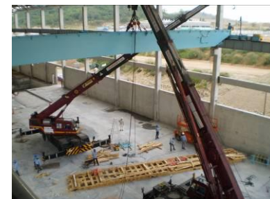
タイでのクレーン上架作業
