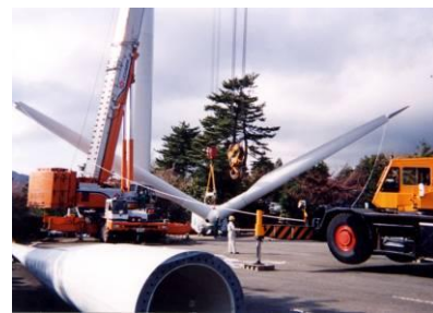
風力発電装置の建柱
