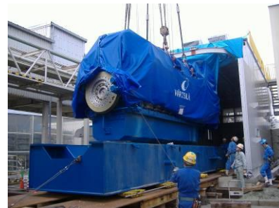
大型機械の据付
