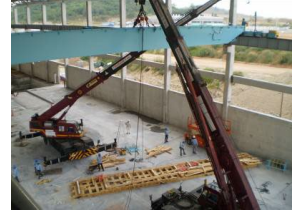
タイでのクレーン上架作業
