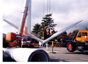
風力発電装置の建柱
